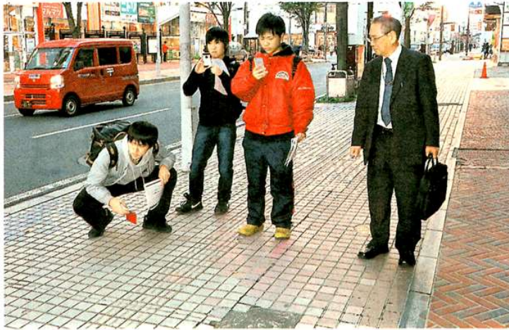
歩道の破損状況を調べ、写真に収める学生ら
